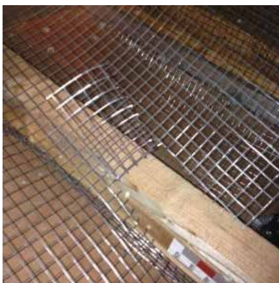
Découpe et pliage du grillage en correspondance des entrants (gauche) et maintien de l'aération (droite)
