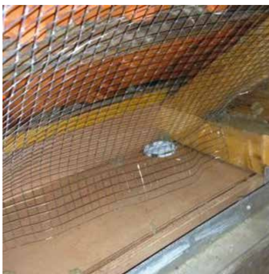
Découpe et pliage du grillage en correspondance des entrants (gauche) et maintien de l'aération (droite)
